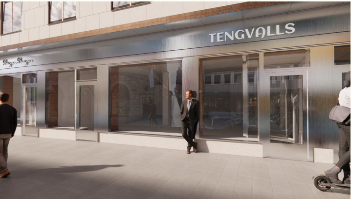
Glaspartier, skärmtak i rostfritt borstat stål. På bild Unit 02a
